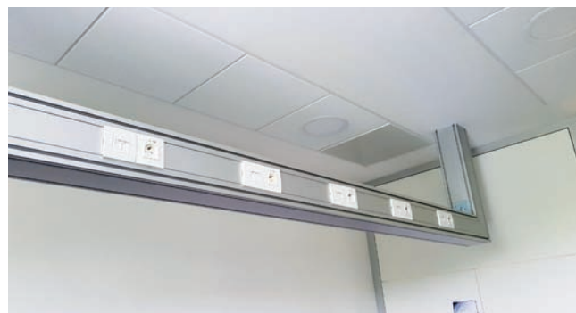
Využitie stĺpu ako rozvodného kanála na výpočtovom pracovisku
